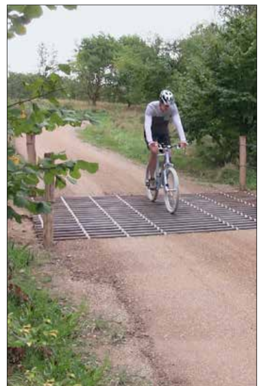
Hier mit Feuerverzinkte Rohren
