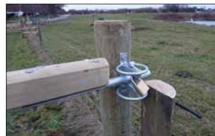
*Die Wegschränke kann in offener und geschlossener Stellung mit einem Schloss gesichert werden. Die Bügel an der Torfalle verhindern Schäden beim Nahkontakt.*
